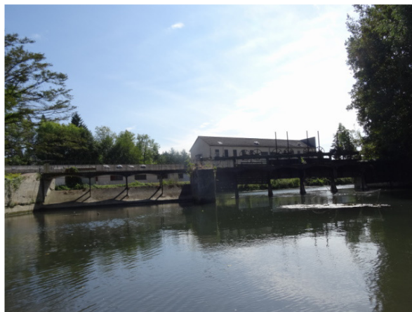
6 – Vannage et déversoir – vue aval
