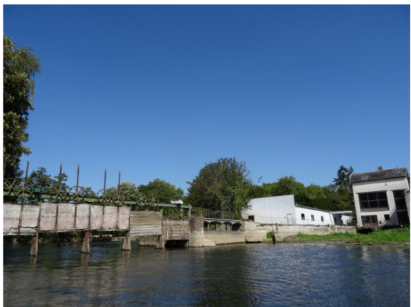
5 – Vannage et déversoir – vue amont
