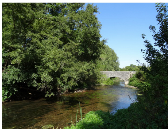
4 – Bief en amont du pont
