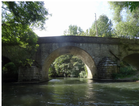
2 – Pont Saint-Jean – bras de décharge principal
